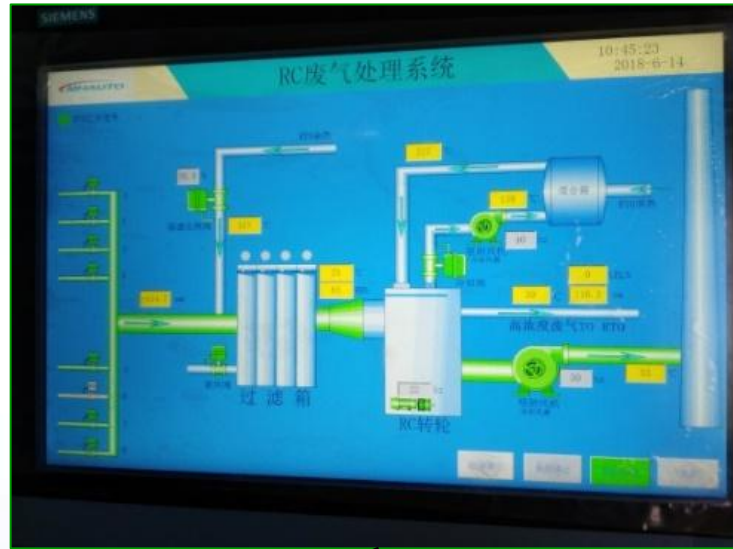
VOCs设备运行显示
